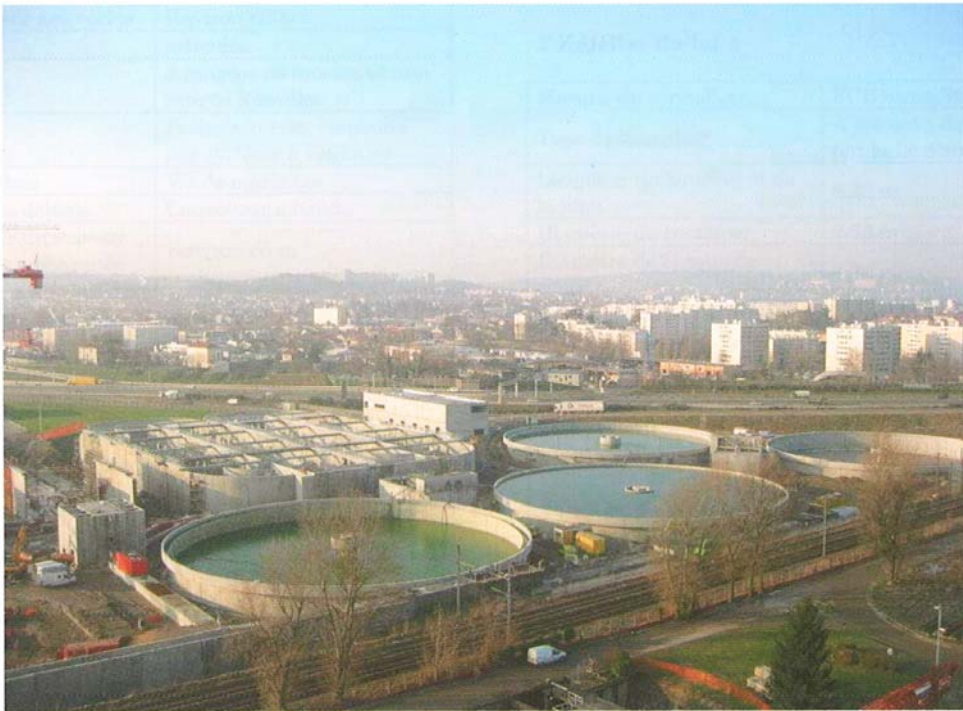
Vue aérienne du projet - Vue de l'extension du traitement biologique
