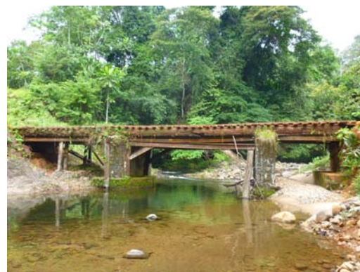
Exemple d'ouvrage d'art renforcé au Gabon
