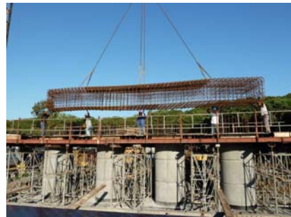
OA5 - Pose du ferrailage préfabriqué du chevêtre de la pile P1
