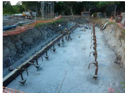
OA5 - Têtes de micropieux de la culée C0
