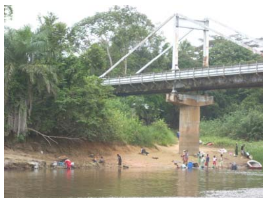
Ouvrage d'art sur la RN 2 sur l'Ogoué
