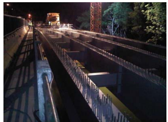
Livraison ossature métallique
