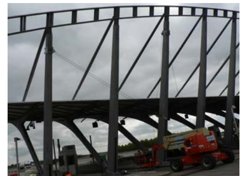
Pose du dernier caisson
