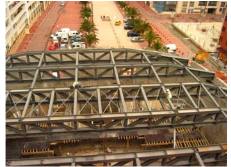
Toiture Bâtiment B
