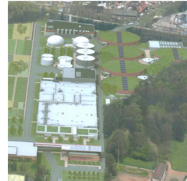
Vue architecturale de la STEP de Marquette-Lez-Lille
