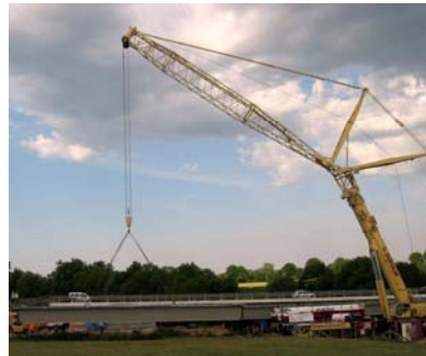
Pose du dernier caisson
