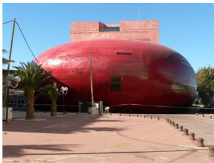
Bâtiment B achevé
