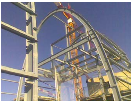
Charpente Bâtiment D
