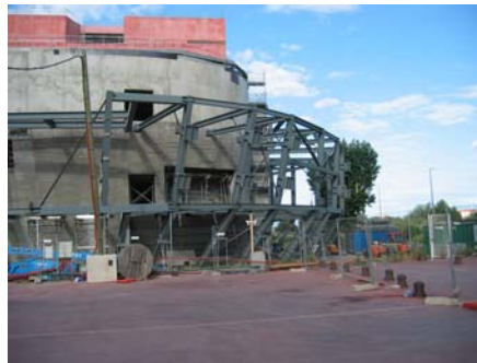
Ossature arc Bâtiment B
