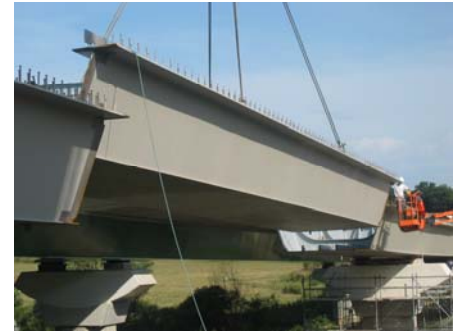
Pose du dernier caisson
