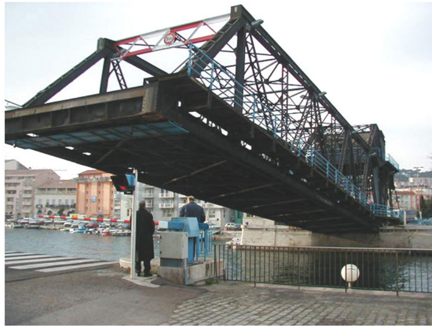
Pont Sadi-Carnot - Réparation du portique d'appui le 15/12/2000 fin des travaux
