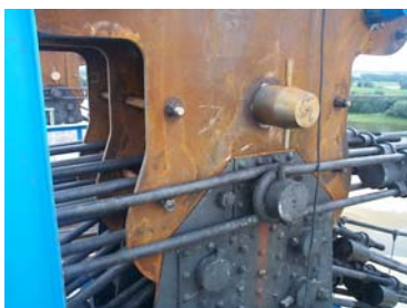
Détail de soudage de la nouvelle selle sur la selle existante
