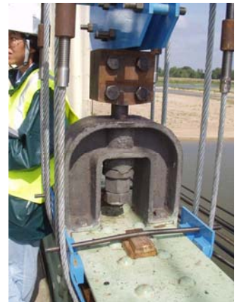
Détail ancrage suspente provisoire
