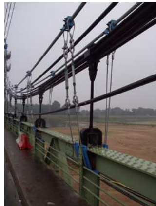
Double suspension (provisoire et définitive)
